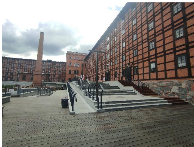
Fot. 1: Przykład projektowania przejścia o zróżnicowanym poziomie trudności: pochylnia, schody z dużą liczbą spoczników i schody klasyczne, autor: K. Rawski.
